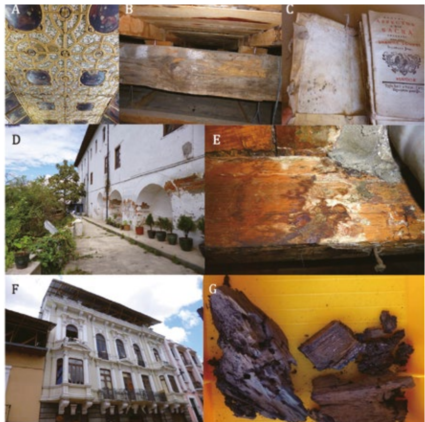
Figura 2. Degradación de madera histórica en Quito. A. Artesonado de la Sala Capitular en el convento de San Agustín, B. Vigas que soportan el artesonado del techo de la Sala Capitular con síntomas de degradación, C. Libros del convento de San Agustín infestados por hongos, D. Vista posterior del Convento de las madres Agustinas, E. Vigas de soporte del convento de las madres Agustinas en degradación, F. Casa Gillespie, G. Madera de la Casa Gillespie en degradación.
