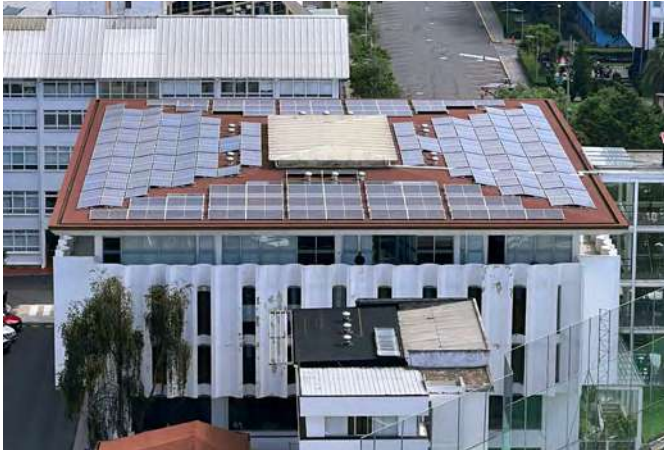
Imagen 66. Instalación del sistema fotovoltaico en la Biblioteca Central
